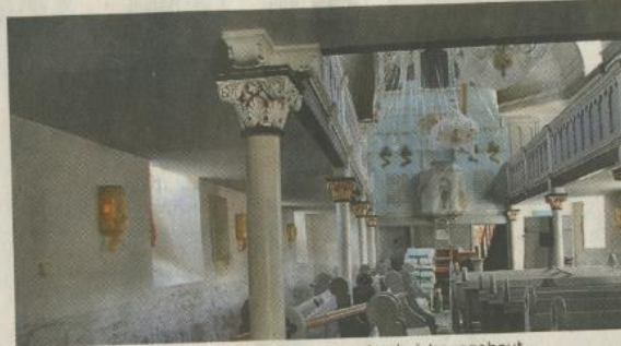
Die Orgel, bei der es Probleme mit Schimmel gab, ist ausgebaut.
