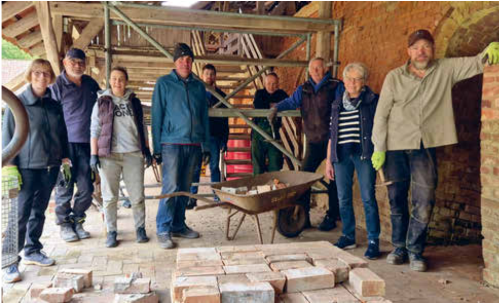
Reparaturmaßnahmen am Ringofen – Arbeitseinsatz 9. Mai 2026
